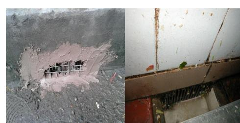
工地食堂和宿舍的墙壁孔隙、洞穴，下水道、通风管道、线路等道口加设防鼠网，防鼠网用铁丝网或不锈钢网，网眼小于13×13mm。
