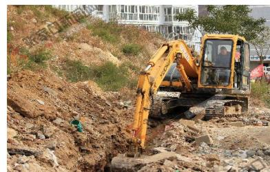
建筑工地沟渠应及时回填夯实；工地内路面保持平整，无明显坑洼、积水。
